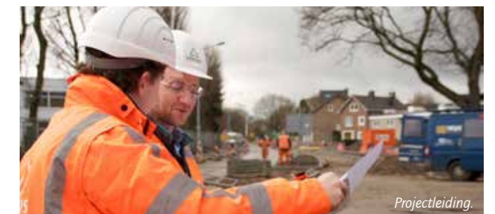
Geotechnisch onderzoek Oudegracht Utrecht.
