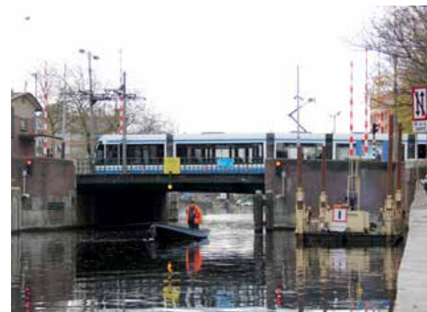
Onderzoek geeft inzicht in de bodemopbouw onder de bestaande kademuren.
